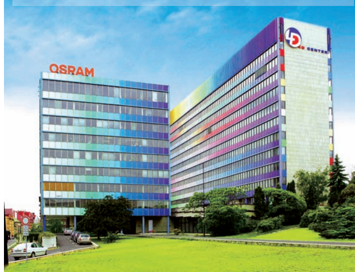
Budova 4D Centra v Kodaňské ulici na Praze 10
